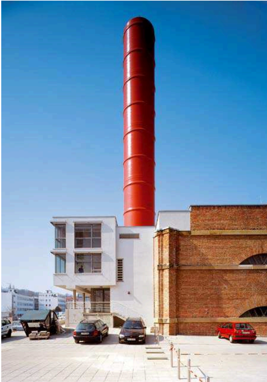
5 Der 30 m hohe Lüftungskamin ist das Wahrzeichen des Theaterhauses in Stuttgart. Bild: Dietmar Strauß.
